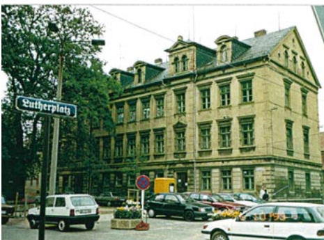
Die alte Lutherplatzschule im Oktober 1993 vor der Sanierung durch die Döbelner Wohnungsbau- und Verwaltungsgesellschaft mbH. Foto: Stadtarchiv Döbeln
