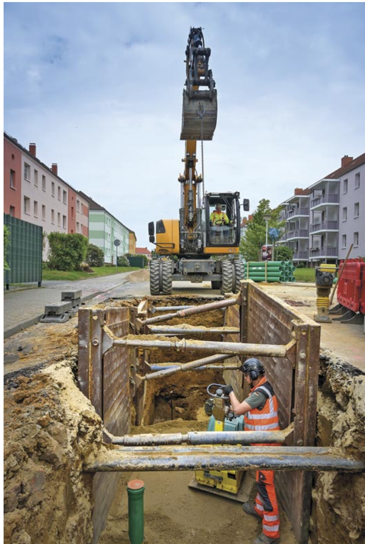
Insgesamt 570 Meter Mischwasserleitung sind in der Döbelner Blumenstraße durch den Abwasserzweckverband neu verlegt worden.
