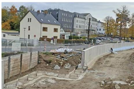
Aktuell laufen die Arbeiten an der zweiten Hälfte der knapp 200 Meter langen Hochwasserschutzmauer an der Sörmitzer Straße in Döbeln. Die erste Hälfte ist fertig. Foto: M. Fricke
