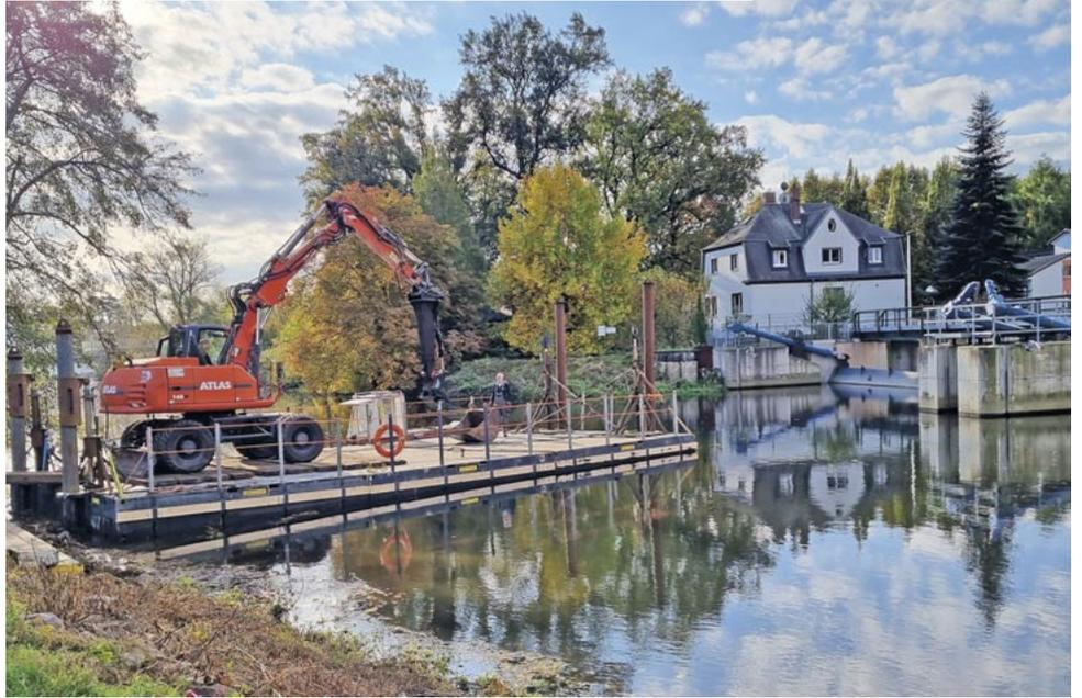
Vor dem neuen Verteilerwehr haben sich Sedimente abgelagert. Damit das Wehr funktionsfähig bleibt, werden die Ablagerungen mit schwimmfähiger Technik aus der Freiburger Mulde geholt. Foto: Maja Köhler
