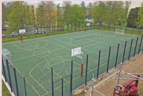
Bereits fertiggestellt ist das Kleinspielfeld im Außenbereich sowie eine Laufbahn hinter dem neu errichteten Schulgebäude.
