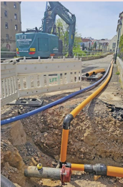
Noch bis August 2026 dauert die Erneuerung des Trinkwasser- sowie Strom- und Gasnetzes in der Staupitzstraße an, dann folgt der Flutschutz. Foto: Maria Fricke
