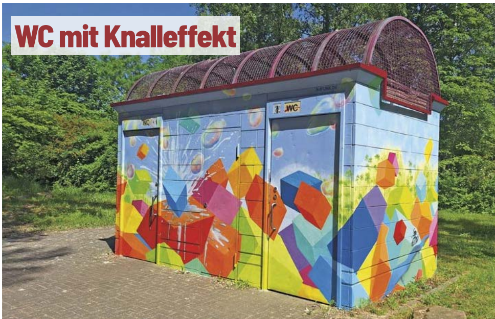
Das Toilettenhaus in der Freizeitanlage „Klosterwiesen“ ist zum knallig-bunten Blickfang geworden. Im Auftrag der Stadt Döbeln hat Künstler Frank Schäfer sich eine kreative Gestaltung für das einst triste Häuschen überlegt. Foto: Christiane Böttger
