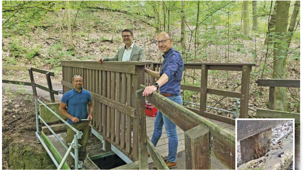
Falk Fischer (links) von der Ebersbacher Firma Bauen ohne Limits hat die neue Brücke in der Kühlen Schlucht in den Roßweiner Anlagen aufgebaut. Oberbürgermeister Sven Liebhauser (Mi.) sowie Uwe Handtrack, Sachgebietsleiter Tiefbau, begutachten den Neubau kurz vor der Freigabe. Die alte Brücke bestand aus Holz und war verwittert (kl. Foto). Foto: M. Fricke/U. Handtrack
