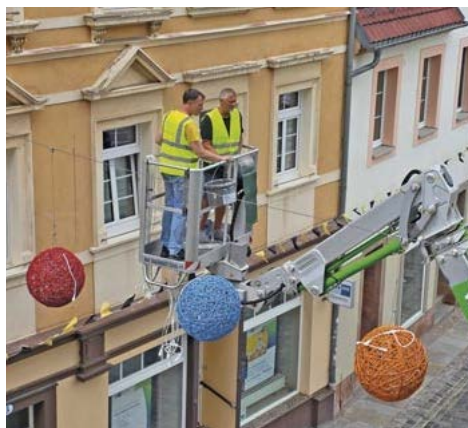
Mitarbeiter des Bereichs Licht-Design der Leipziger Firma New Energy Leipzig haben am 4. Juni die Beleuchtung in der Stadthausstraße angebracht. Foto: Maria Fricke
