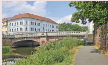
Im Zuge des Baus des Hochwasserschutzes entlang des Wappenhenschstiftes wird auch die Fußgängertreppe an der Oberbrücke erneuert. Foto: M. Fricke
