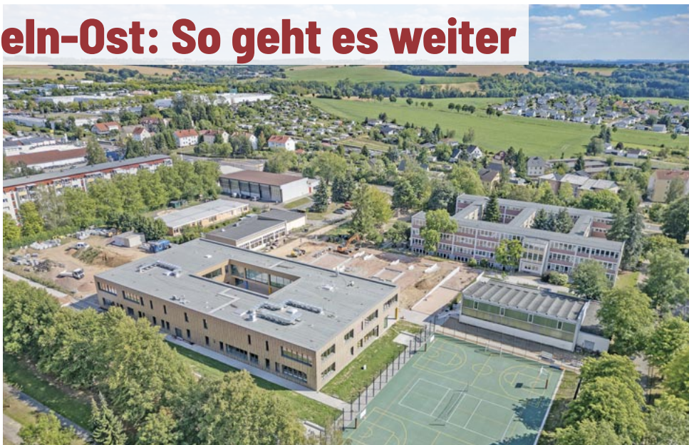
Vorn im Bild zu sehen ist der Neubau der Grundschule Döbeln-Ost. Der Umzug von der alten Grundschule (im Bild hinten rechts) ist für die Herbstferien geplant. Im Bereich der alten Grundschule (Baujahr 1969) soll eine 1,5-zügige Förderschule mit Sporthalle und den erforderlichen Außenanlagen neu gebaut werden. Der erste Schritt dafür ist gemacht. Foto: L. Weidler
