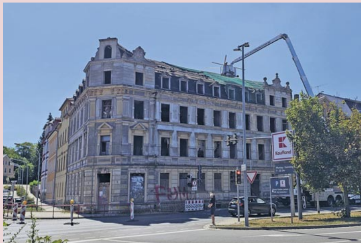
Mitarbeiter des Dachdeckerbetriebes Kunze aus Jahnatal haben im Auftrag der Stadt das Dach des Gebäudes Schillerstraße 41 mit Netzen notgesichert.
