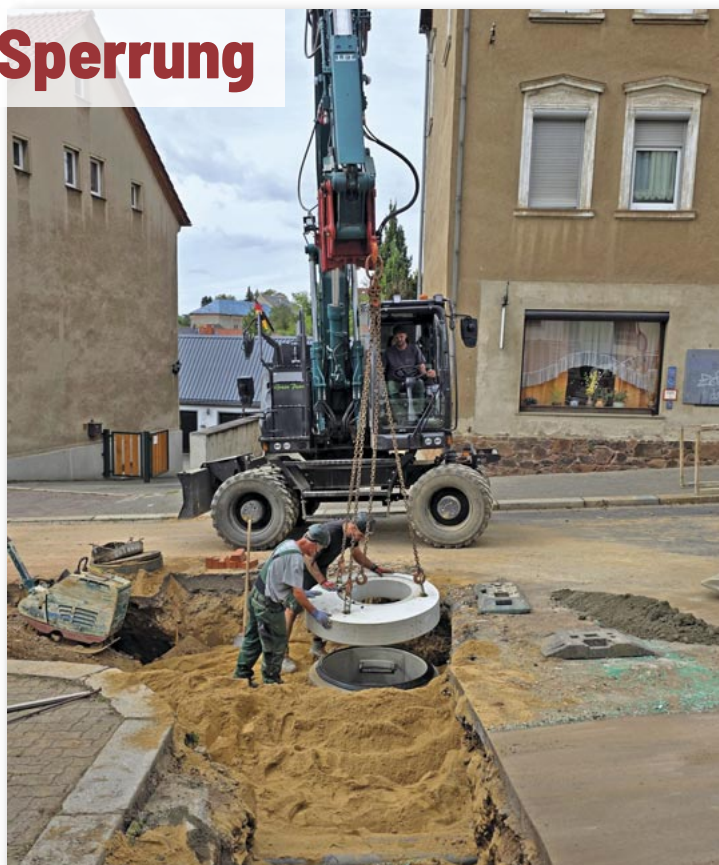
Mitarbeiter der Firma LFT Straßen- und Tiefbau GmbH montieren die Schachtabdeckung auf dem neu errichteten Schacht in der Leipziger Straße. Dieser war in einer Tiefe von fast vier Metern so marode, dass sich bereits die Straße abgesenkt hatte. Foto: Maria Fricke
