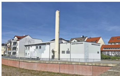
Seit 2010 versorgt das Blockheizkraftwerk am Nieder- werder die Kunden der Stadtwerke in der Innenstadt mit Nahwärme und elektrischer Energie. Foto: M. Fricke
