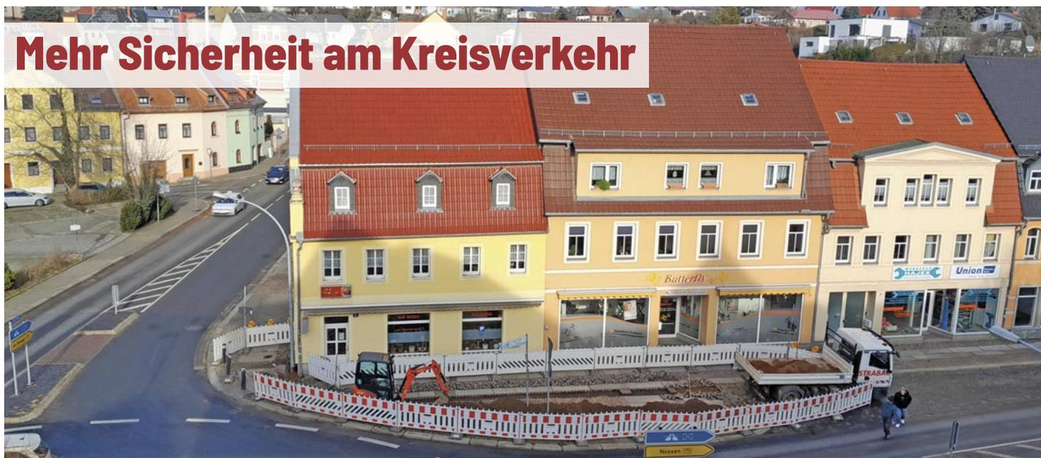
Mitarbeiter der Firma Strabag AG haben im Bereich des Gehweges an der Sankt-Georgen-Straße die Kabel für die neue, weiße LED-Beleuchtung am Kreisverkehr an der Oberbrücke verlegt. An allen drei Ein- sowie Ausfahrten werden zukünftig Fußgängerüberwege mit Zebrastrifen gekennzeichnet und entsprechend ausgeleuchtet. Foto: Maria Fricke
