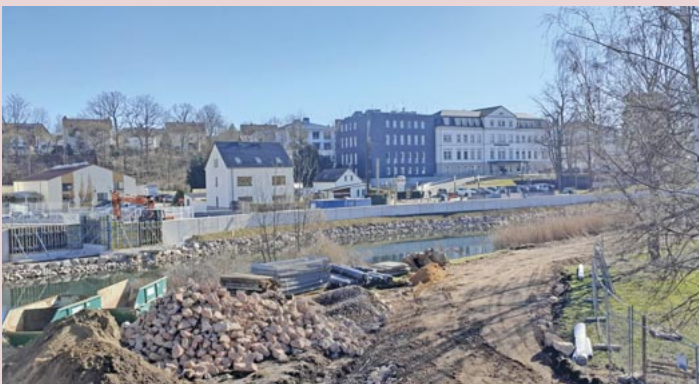
Im Hintergrund ist entlang der Sörmitzer Straße die fast fertige Hochwasserschutzmauer zu sehen. Anfang März wurde dort am Tor der Mauer gearbeitet. Im Vordergrund ist die neue Flutbaustelle entlang der Thielestraße zu erkennen. Die Firma Hundhausen hat im Februar mit der Errichtung einer Baustraße entlang des Muldenufers begonnen. Foto: Maria Fricke
