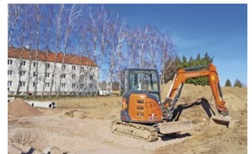
In Lüttewitz ist mit den vorbereitenden Arbeiten für den Bau des neuen Gerätehauses begonnen worden. Foto: M. Fricke
