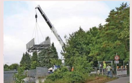
Komplett montiert hob ein Autokran die neue Brücke am Wasserkraftwerk in Großbauchlitz vorbei auf ihre zukünftige Position. Foto: Th. Mettcher
