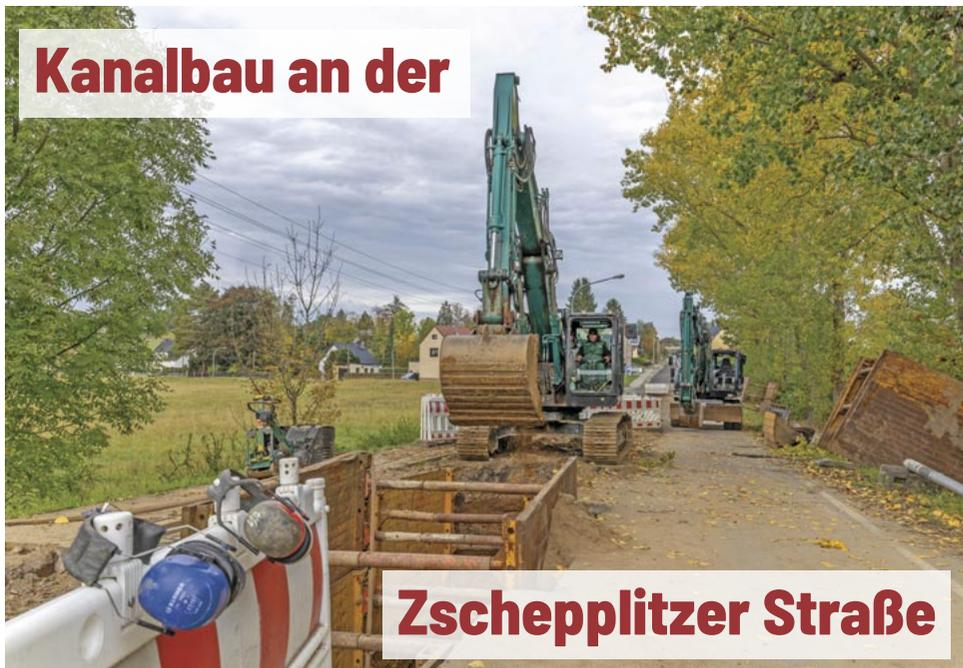
Seit dem 30. September 2025 ist die Hauptverkehrsader in Döbeln-West dicht. Der Abwasserzweckverband Döbeln-Jahnatal lässt in der Zschesplitzer Straße zwischen dem Ortseingang Döbeln und dem Abzweig Schnitterstraße durch die Firma LFT aus Jahnatal einen neuen Misch- sowie einen neuen Schmutzwasserkanal verlegen. *Foto: Lutz Weidler*
